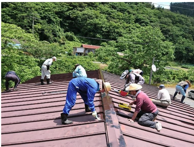
左の写真：会館の屋根補修作業の様子(令和2年)
