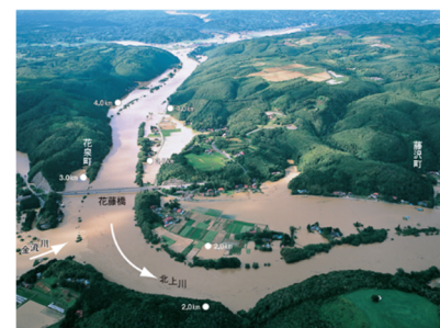
岩手河川国道事務所『平成14年7月 台風6号洪水 北上川上流水害写真集』より
